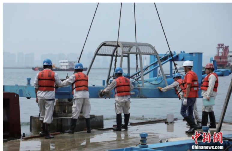
图为8月5日，安装现场。
