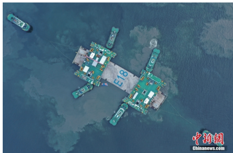
8月5日晚，由中交一航局承建的中国北方首条大型跨海沉管隧道——大连湾海底隧道最后一节沉管E18管节顺利完成安装，至此，大连湾海底隧道沉管安装任务全部完成。20个月完成18个沉管精准安装任务，创造了世界跨海沉管隧道建设史上安装速度最快、用时最短的新纪录。图为8月5日，安装现场。（无人机照片）
